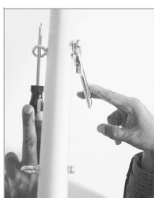
Рисунок 9: Закручивайте болты двумя пальцами.
